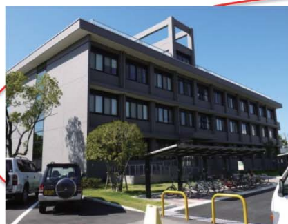
理工学部3号館
