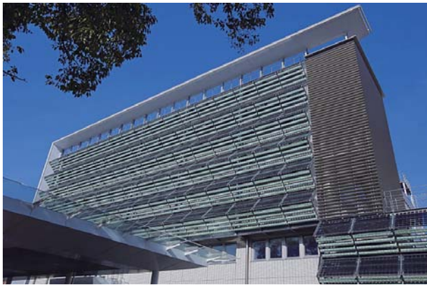
太陽光パネル設置 (病院南診療棟)
