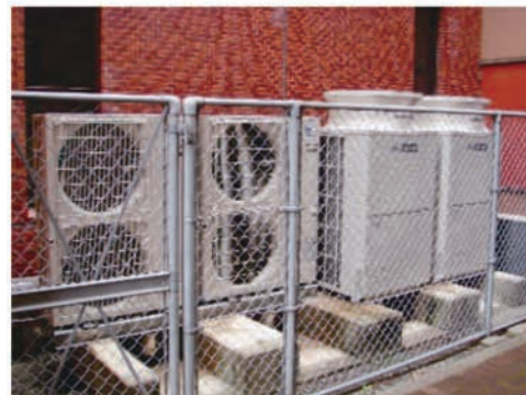
高効率空調機へ改修した建物 (2019年度 看護学科棟 室外機置き場)
